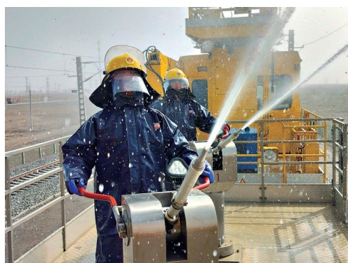
铁路养护人员在青藏铁路上清洗盐湖沿线电网绝缘子。周悦翔 摄
