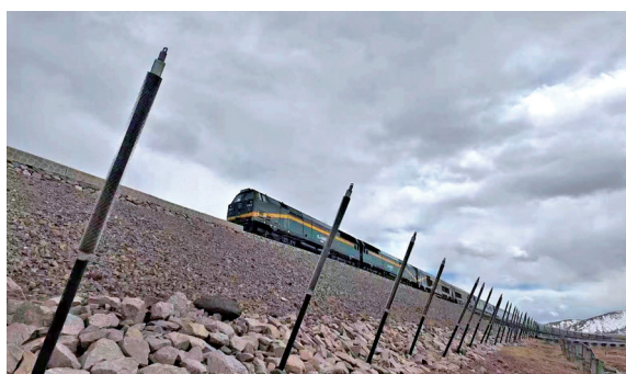
在青藏铁路冻土区段植入的热棒,承担着锁定冻土温度的功能。王则斌 摄
