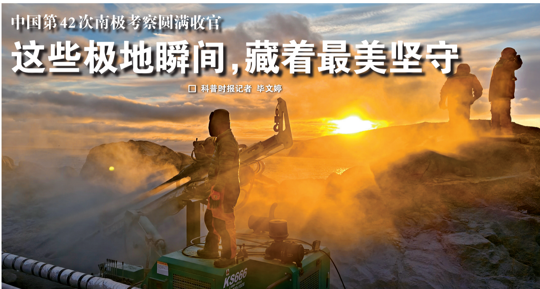
2026年2月,考察队员在南极秦岭站进行海水取水管路施工。周景武 摄
