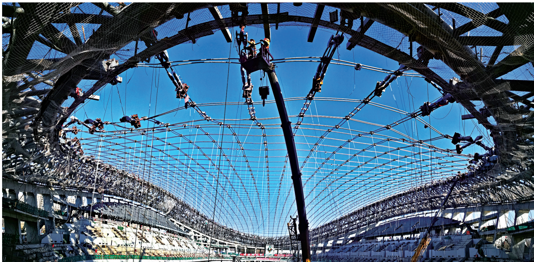
2019年1月25日,北京冬奥会国家速滑馆工地,工人正在进行屋面索网结构施工。黎方益 摄
