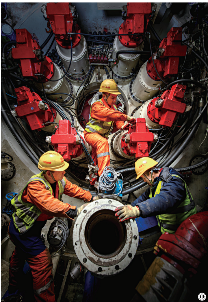
图①: 2023年12月31日,湖北武汉地铁12号线石桥站(埋深36米)盾构机完成组装调试,该工程攻克了高水压及复杂地质难题。
