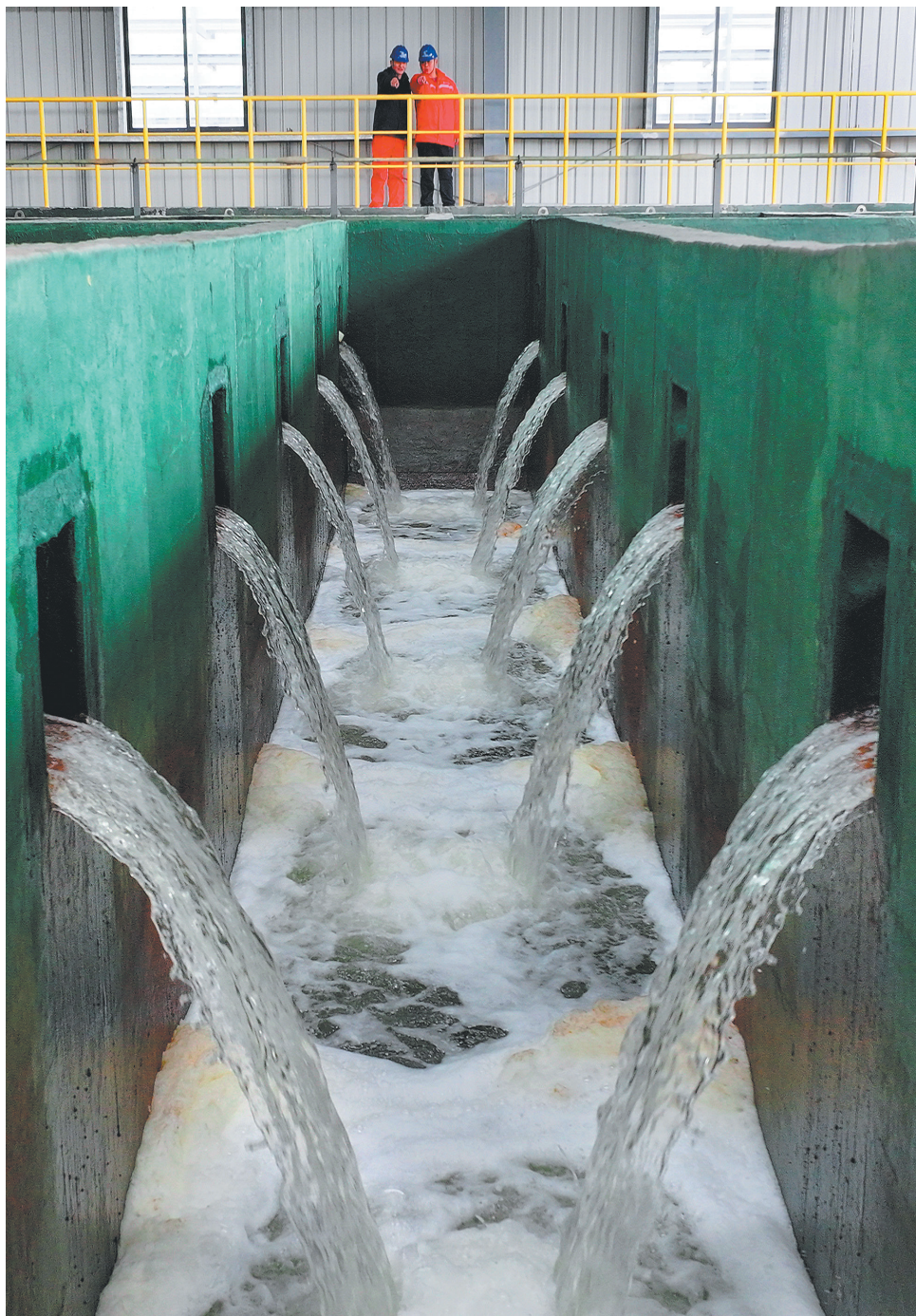
经过混凝池沉淀的海水,从这里转入下一个处理环节。
