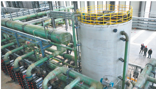
脱盐和分离重金属等有害离子是膜滤车间主要任务,经过前期处理的海水在这里完成淡化。
