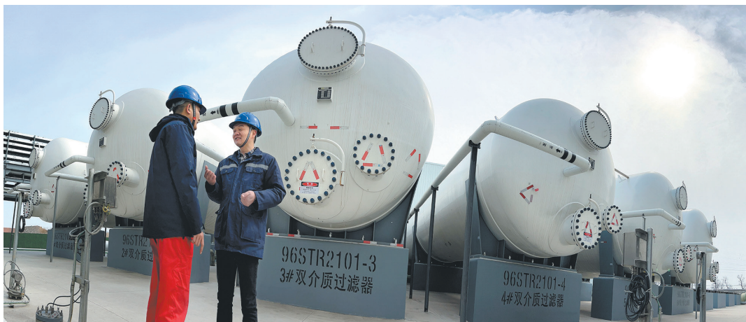
6台巨大的双介质过滤器以接力的方式“筛掉”絮体、藻类等颗粒,为海水“瘦身”。
