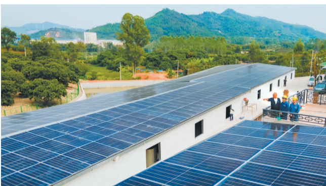
2024年11月3日，广州市从化区太平镇莲塘村，电力工人在“瘦身鱼”养殖场沟通光伏并网发电接入需求。 崔宏彬 摄
