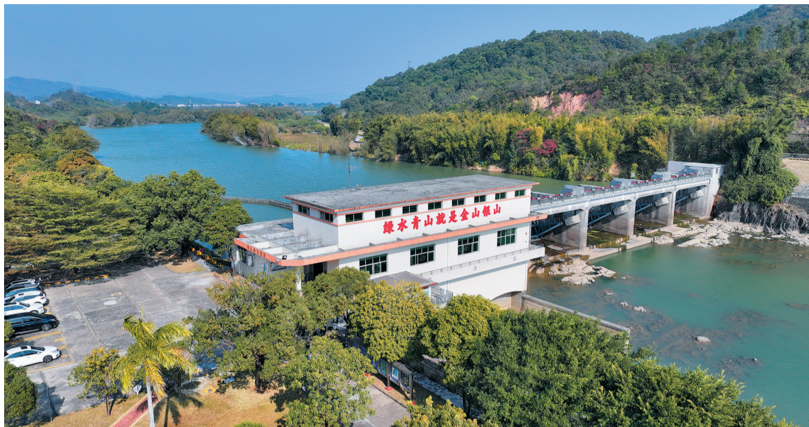
2024年12月28日，广州市从化区太平镇，横跨于流溪河上的牛心岭水电站，将源源不断的水能转变成电能输送到千家万户。
