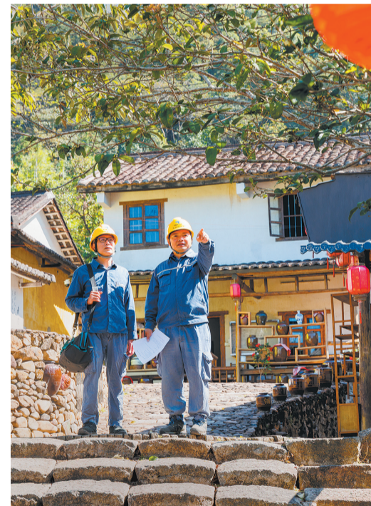
2024年11月3日，广州市从化区吕田镇供电所电力工人在莲麻村进行用电检查。 崔宏彬 摄
