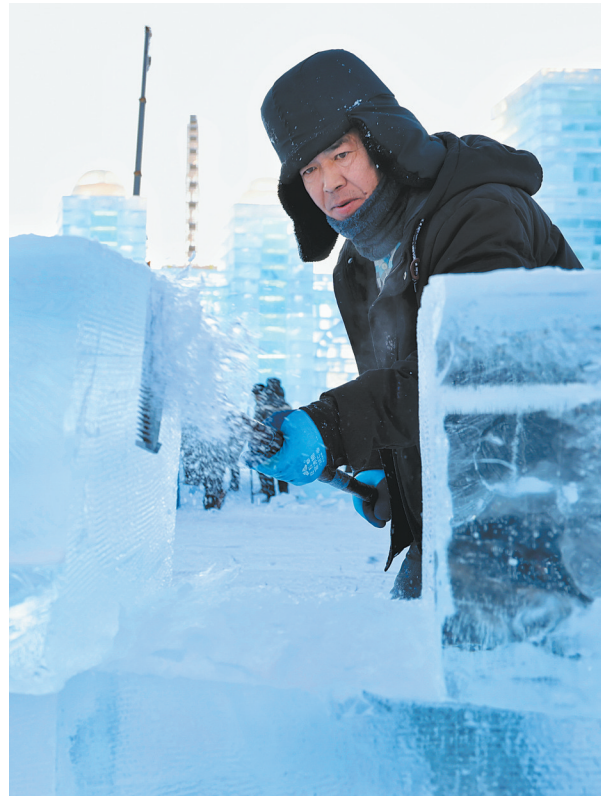
12月16日,工人用修冰刀在冰块上打出沟痕,以强化冰块之间浇筑粘合的稳定性。杨威 摄
