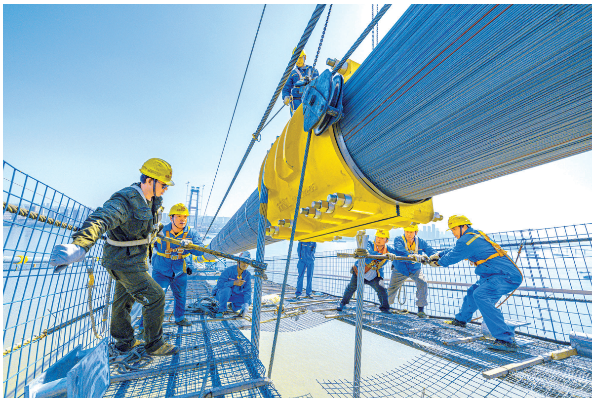
2018年10月28日,武汉杨泗港长江大桥施工现场,工人们在距江面200多米的猫道上安装悬索拉杆,将大桥稳稳地“锁定”在大江之上。 黄蕾 摄
