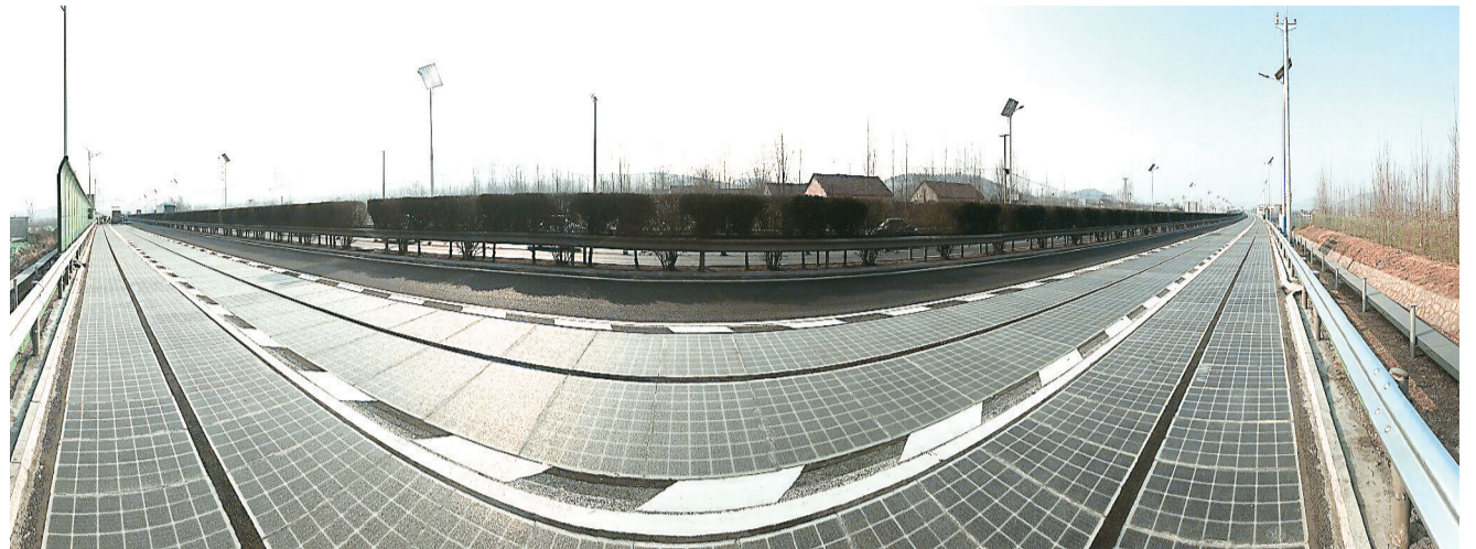
山东省济南市一条光伏高速公路建成并正式通车。图为光伏高速公路路面。视觉中国供图
