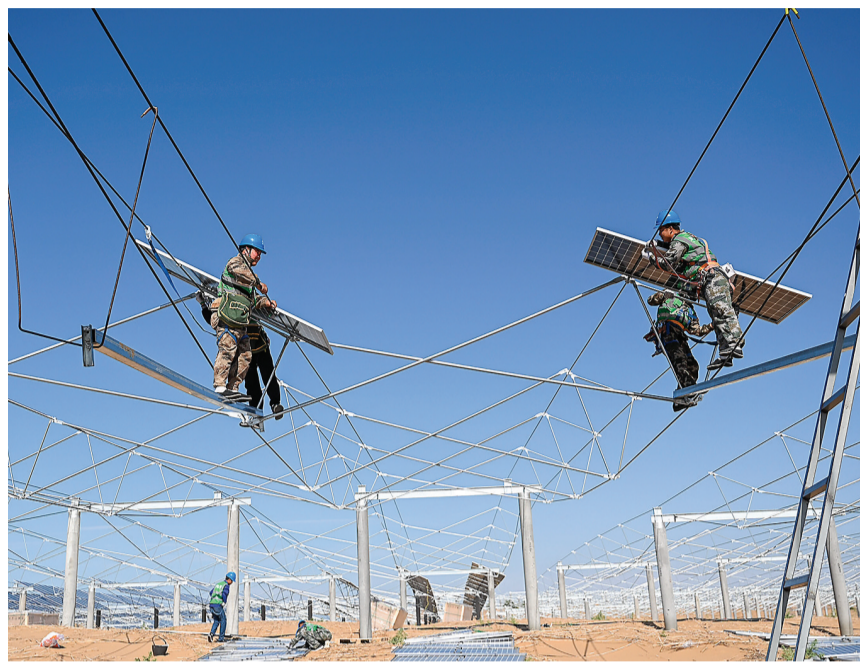
位于内蒙古杭锦旗库布其沙漠亿利生态示范区的蒙西基地库布其200万千瓦光伏治沙项目，目前进入光伏板安装环节。该项目预计2024年底前实现全容量并网发电，建成后年平均可供应绿色电力约40亿千瓦时。图为工人在光伏治沙项目现场施工。
