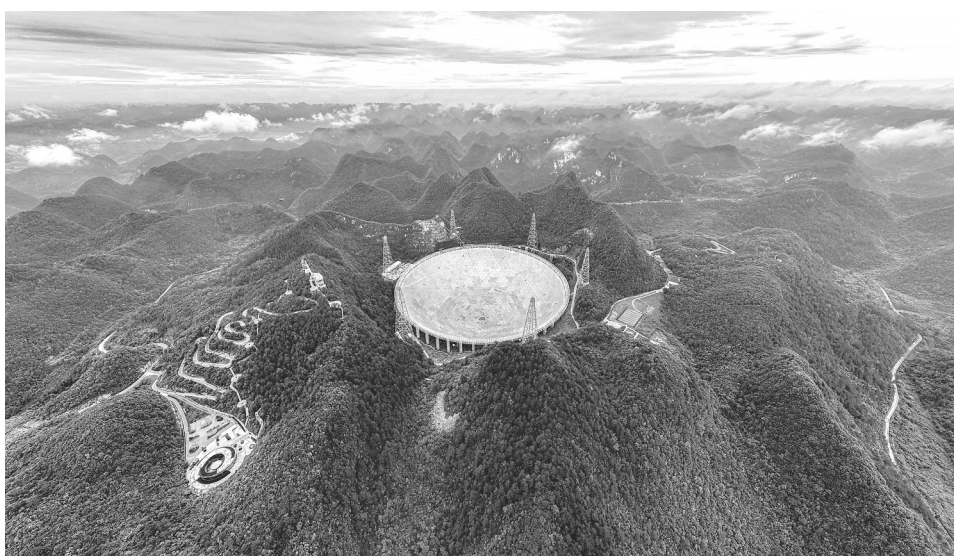
6月23日拍摄的“中国天眼”全景(无人机照片)。
