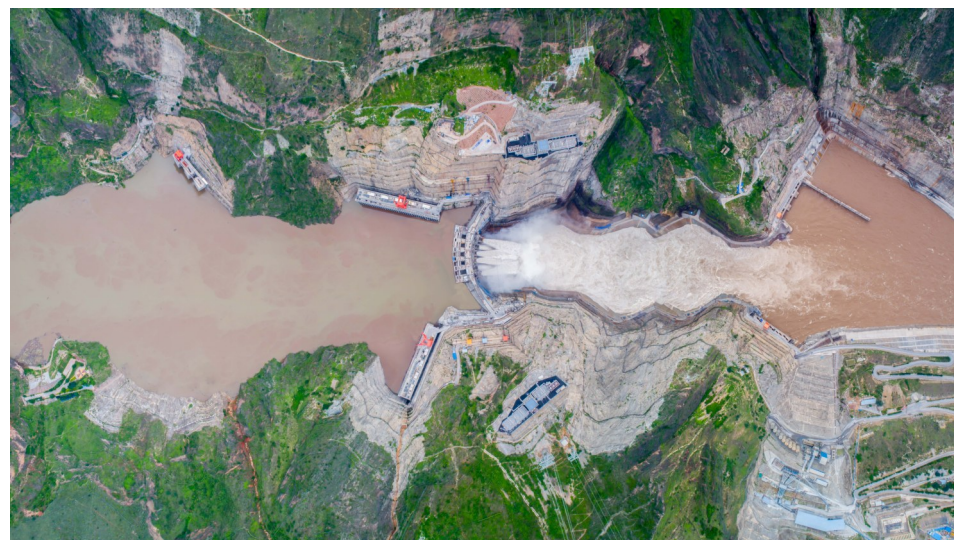
航拍乌东德枢纽区施工全景 许键 摄
