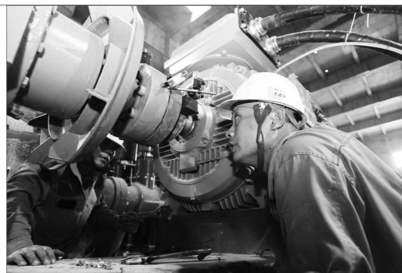
近日,中石化镇海基地煤焦制氢装置建设加快推进开工确认工作,全力冲刺9月底开车一次成功目标。该项目是镇海基地公用工程系统重要装置之一,项目建成后可为生产装置供应氢气及燃料气。目前,项目团队持续做好加热炉烘炉、核心机泵安装调试工作。图为技术人员正在对高压浆泵进行安装调试。 陈卫民 华赞 摄
