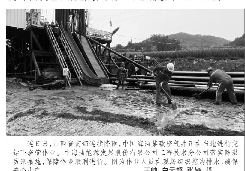
连日来,山西省南部连续降雨,中国海油某致密气井正在当地进行完钻下套管作业。中海油能源发展股份有限公司工程技术分公司落实防洪防汛措施,保障作业顺利进行。图为作业人员在现场组织挖沟排水,确保安全生产。
