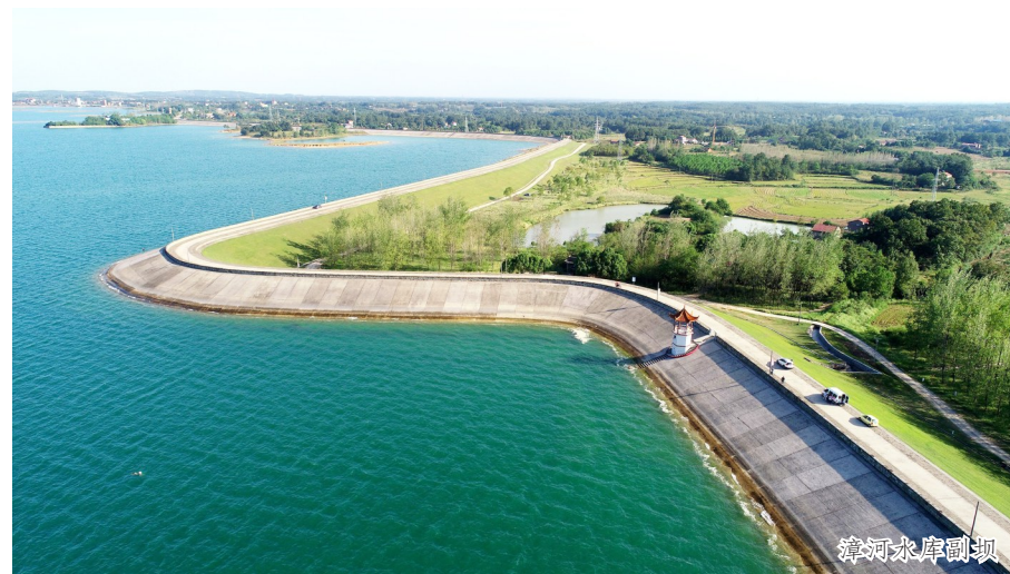
漳河水库副坝
