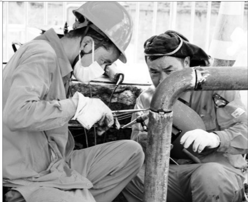
7月27日7时至29日7时，西南油气田公司重庆气矿完成丹7井中心站场站工艺第一阶段停气碰口任务，恢复向重庆璧山天然气有限责任公司供气15万方米。这是重庆气矿对老场站进行工艺改造，提升供气能力的阶段性成果。图为员工仔细检查焊口。 李传富 摄
