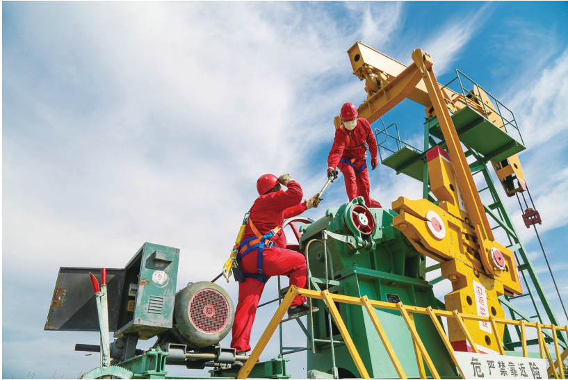
图为采油五厂员工进行调整抽油机游梁平衡作业。
