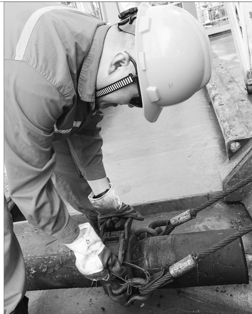
在胜利石油工程公司海洋钻井公司新胜利五平台,“单根吊卡”的新工具现场试用后,效果明显。钻井作业甩配钻具时需要用到钻具提丝,由于比较重,过去要由两个人协同完成上卸扣作业,费时费力,又存在一定的安全风险。新胜利五平台技术攻关小组多方比对、咨询,试用“单根吊卡”代替“钻具提丝”,既满足了安全标准又减轻了工作量。 王为 李彩蒙 摄
