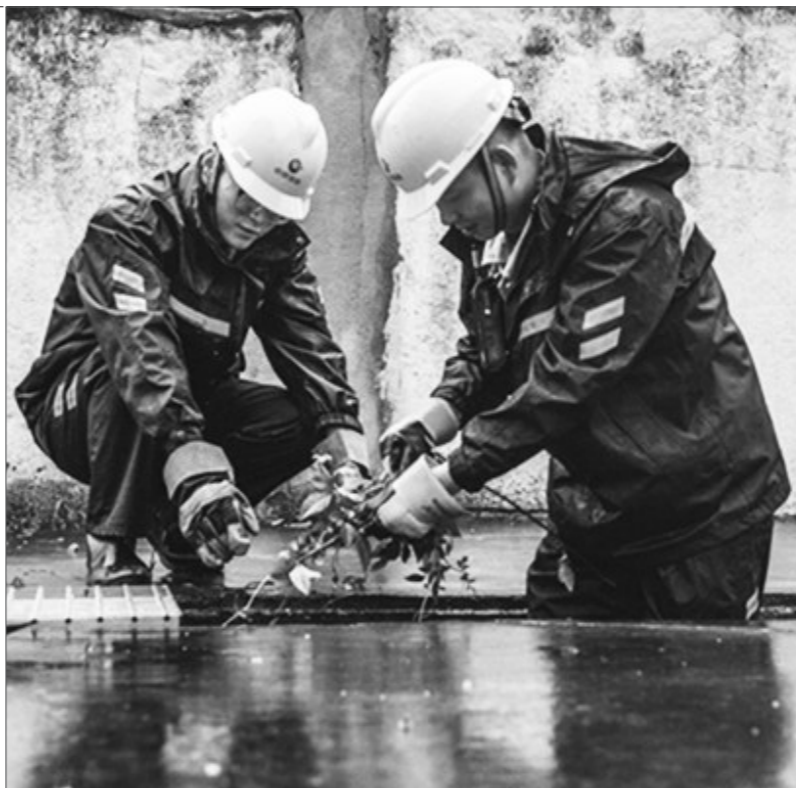
近日,浙江雨水丰沛。中海石油宁波大榭石化有限公司提前做好大风暴雨期间的应急处置工作。6月10日,操作人员对装置地漏、水沟等疏水系统进行畅通性检查,及时清理雨水沟里的杂物,力保各装置在夏季汛期能正常生产。
