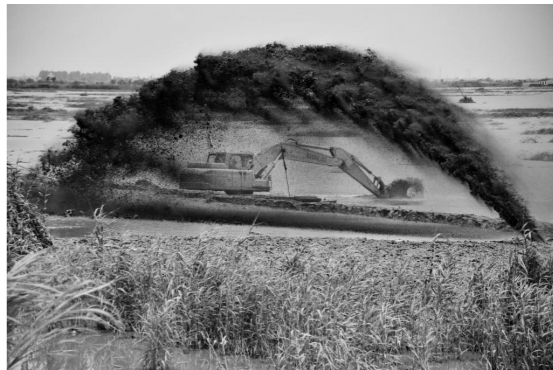
图为洪湖沿岸,挖泥设备正在进行疏浚整治。
