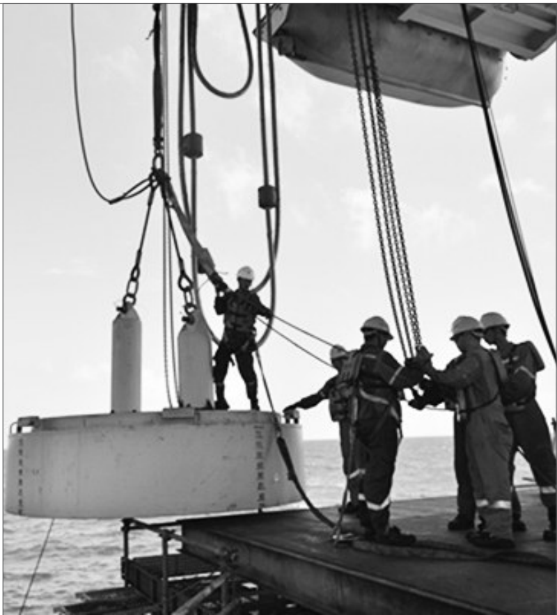
5月19日,中海油有限公司湛江分公司文昌13-1平台导管架阳极延寿项目,取得突破性进展。作业人员成功将首块重达9吨的重力基础安装至海平面以下117米的泥线位置,为后续重力基础的吊装奠定了坚实基础。 杨舒伦 陈经锋 摄
