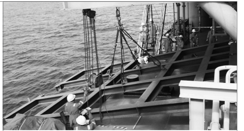
5月6日,中海油有限公司深圳分公司恩平油田作业区“海洋石油118”FPSO(浮式生产储卸油装置),精准完成潜水系统底座的吊装工作,为后续单点锚链修复和潜水作业的顺利进行做好了铺垫。潜水架底座长9米、宽7米,重6.8吨,吊装难度大,现场人员谨慎操作,密切配合,确保潜水系统底座安全就位。吴晨 摄
