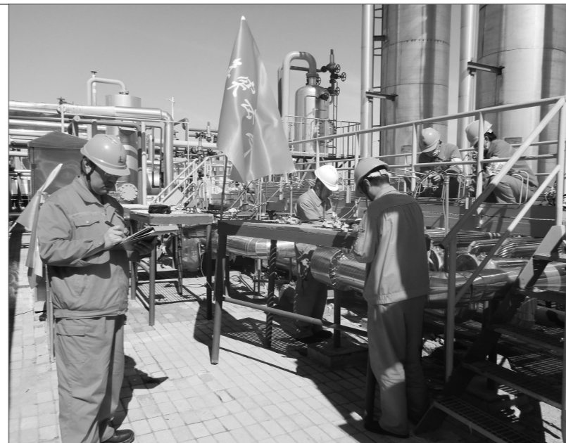
在中石化胜利油田油气集输总站孤岛天然气处理站轻烃装置区检修现场,青年突击队对各项施工作业从安全规范、绿色环保、质量控制角度进行全面监督检查,坚决杜绝各类隐患,为施工任务安全优质完成提供了有力保障。
