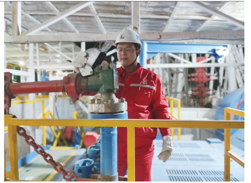
张希杰在钻井现场操作设备。
