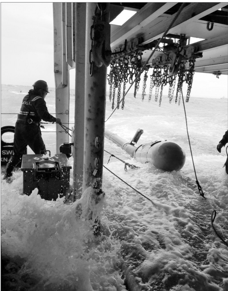
5月5日,中海油服物探事业部“滨海517”船队,在涠西南进行海底电缆地震采集作业。震源组长邓永进利用牵引绳减少大风浪造成枪阵浮体大头的摆动,避免浮体大头碰撞损坏,保障震源设备安全。周艺 摄
