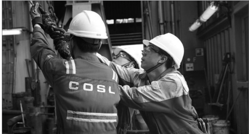
春节期间，中海油“海洋石油982”钻井平台正在荔湾13-2区块进行三开井段作业。为保障节日期间安全生产，平台在作业中严格落实重大高风险作业管控措施，全员坚守岗位，确保作业安全有序高效开展。图为钻井在井口准备安装套管动力卡瓦。杨毅 摄
