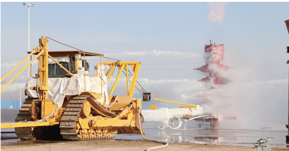
图为应急抢险队员在实施旧井口水力喷砂切割作业。
