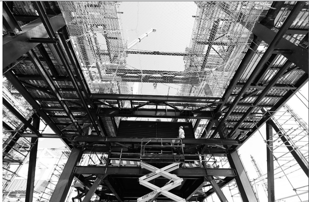
图为东区新建220吨锅炉空气预热器。
