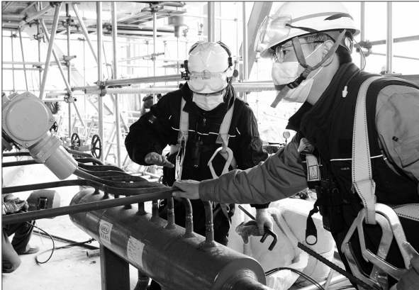
东区新建220吨燃气锅炉，图为工作人员正在对设备充水情况进行检查。
