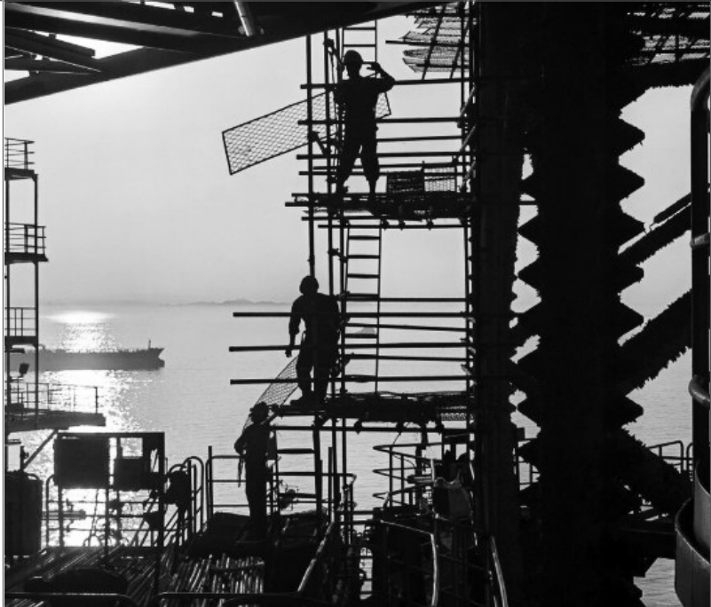
1月8日，“海洋石油943”钻井平台对桩腿进行探伤作业，保障平台结构安全。“海洋石油943”钻井平台正在深圳友联船厂进行五年特检坞修，全体员工奋战在坞修一线，“外委、检修、自修”同时进行，全力提质增效，加速坞修项目进程。本次特检坞修预计工期25天，截至目前“海洋石油943”钻井平台共计完成自修项目50余项。 图为员工在搭建桩腿脚手架，为桩腿探伤作业做准备。 张向升 摄
