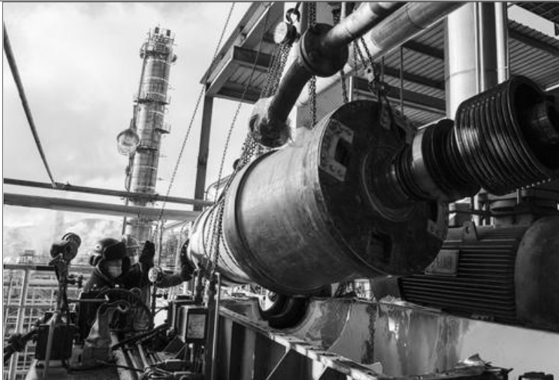
1月12日，吉林石化高密度聚乙烯装置减速机转子更换作业顺利完成，确保了生产设备完好运行。吉林石化针对装置冬季低温生产运行实际，全面检测重点设备设施安全性。生产部门与设备检修部门密切配合，对存在隐患的设备设施采取维护、检修、拆除等有效措施，确保装置冬季生产周期平稳运行。 图为技术人员正在回装减速机转子。 王英刚 摄
