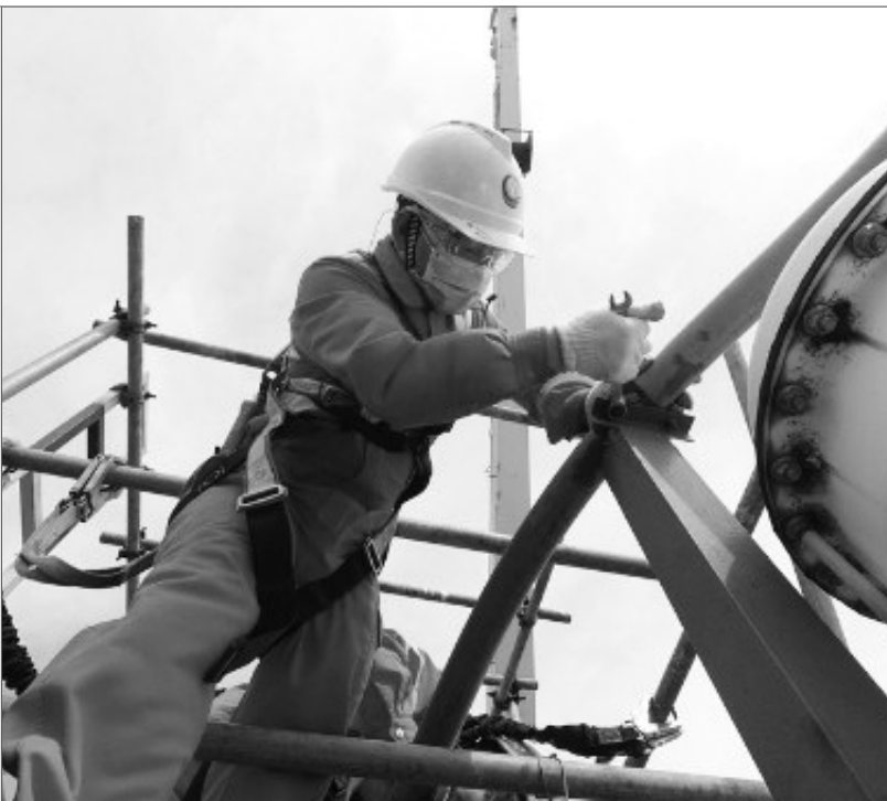
11 月 16 日，中海石油气电集团有限责任公司福建 LNG（液化天然气）开展罐内泵电缆维护作业。为全力冲刺年度目标，福建 LNG 针对重点区域、关键设备设施，制订严格的专项检修方案，做到责任到人、平稳供气。图为作业人员维护接头螺栓。
