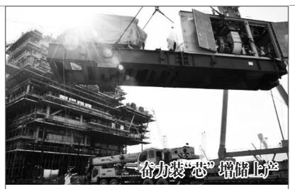
国庆、中秋期间,曹妃甸6-4油田开发项目建造正紧锣密鼓按计划 进行,施工人员安全、精准、高质量完成该项目两台主发电机的装"芯"就 位工作。该项目将为油田增储上产、落实"七年行动计划"作出贡献。
