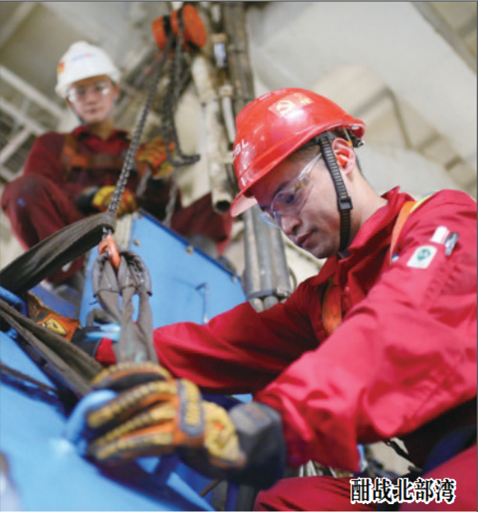
国庆前,“南海四号”钻井平台在涠洲12-4-1d井进行预探井作业,平台上115名员工坚守岗位,全力以赴奋战作业现场,保障各项作业安全有序开展,为北部湾油气勘探开发积极贡献自己的力量。 据统计,中海油田服务股份有限公司钻井事业部在国内共有51艘钻井平台分布于渤海、南海西部、南海东部等海域作业,公司部署安全管理,紧盯台风动向,加强重大高风险作业管控,力保安全。 图为设备班组成员正在拆检泥浆泵链条箱。王振宇 晏树奇 王豪 黄栋 摄
