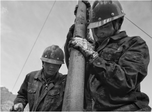
图为井下作业分公司新疆项目部员工在钻探现场进行起下单根作业。
