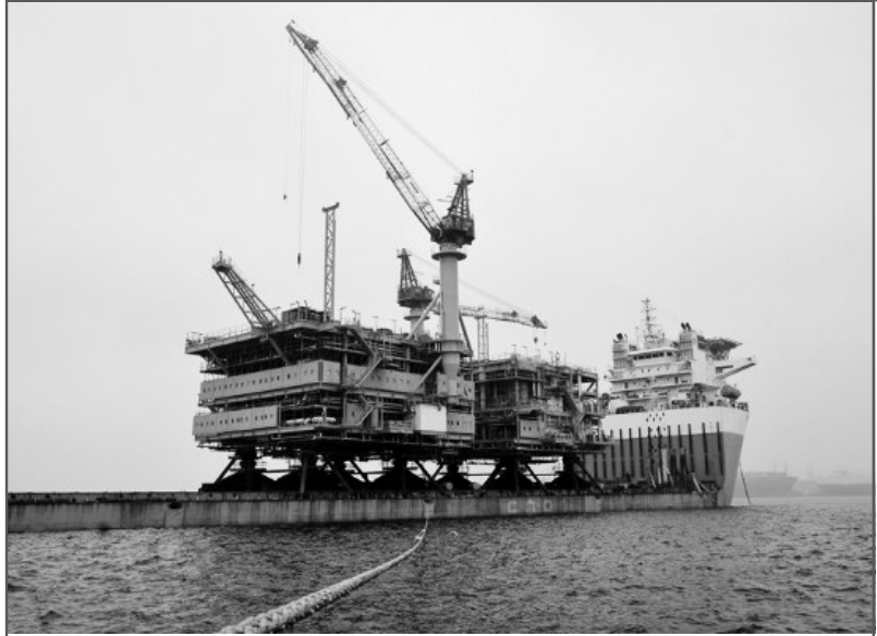
8月16日，高温潮湿的天气让中海油海洋石油工程股份有限公司建造事业部青岛场地码头变成了一个巨大蒸笼。当日，在施工人员的共同努力下，蓬勃作业公司所属油田一个项目WHPL东组块被安全拖拉至“海洋石油278”大型运输船预定区域并精准就位，这标志着该项目陆地建造完成。图为WHPL组块在“海洋石油278”大型运输船预定区域安全、精准就位。
