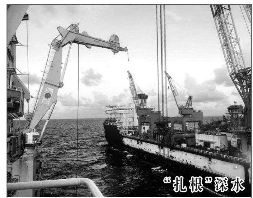
7月5日下午5点,陵水17-2项目海上现场第一根锚桩顺利完成打桩贯入,就位精度和贯入深度均符合要求。图为该项目在1500米级水深进行深水打桩,标志着中国海油已掌握深水打桩技术。
