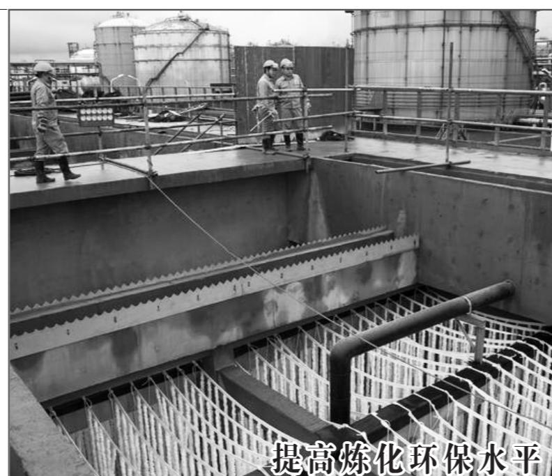
7月16日,中石化镇海炼化炼油污水处理场异地改造项目部分一体化生物反应池开始进水培菌,为实现8月底前项目建成创造积极条件。该项目是镇海炼化处理能力最大的污水处理场,具有土建施工难度高、混凝土浇筑施工量大等特点。镇海炼化坚持加大整体统筹、方案优化的力度,生产部门及时对生化污泥后路、倒排系统配套管线网络、开工网络等影响投用的关键问题进行协调处理,确保按期完成阶段性目标任务。项目建成投用后,将实现镇海炼化所有污水处理单元集中管理,有效解决现有污水处理场能力不足、抗冲击能力差等问题,持续提高镇海炼化环保水平。
