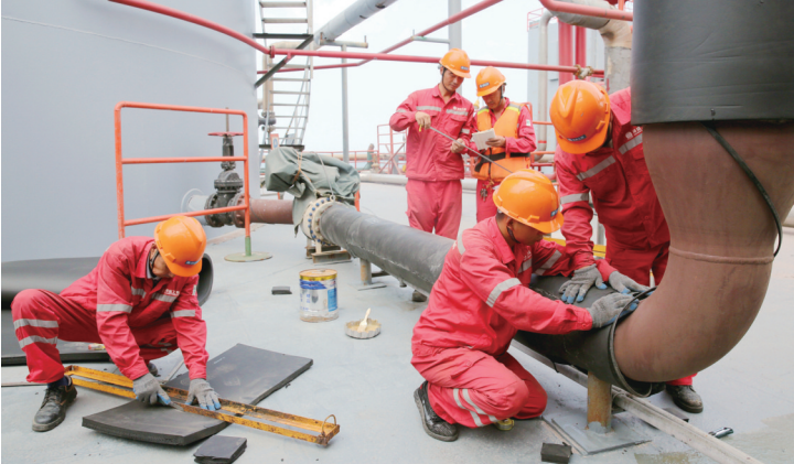
图为海上员工给输油管线加装保温材料
