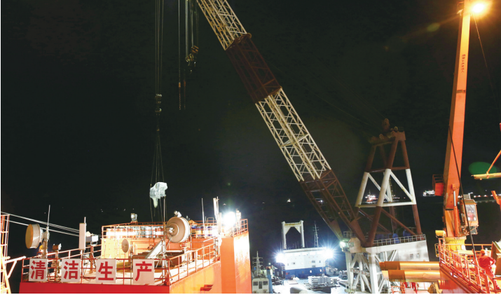
图为胜利海上油田顺利完成中心一号平台2号轮机发电机组吊装就位
