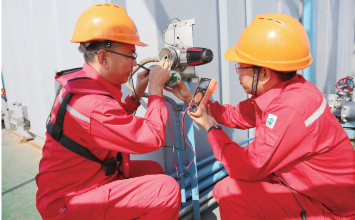
图为海上员工自主维修可燃气体报警器
