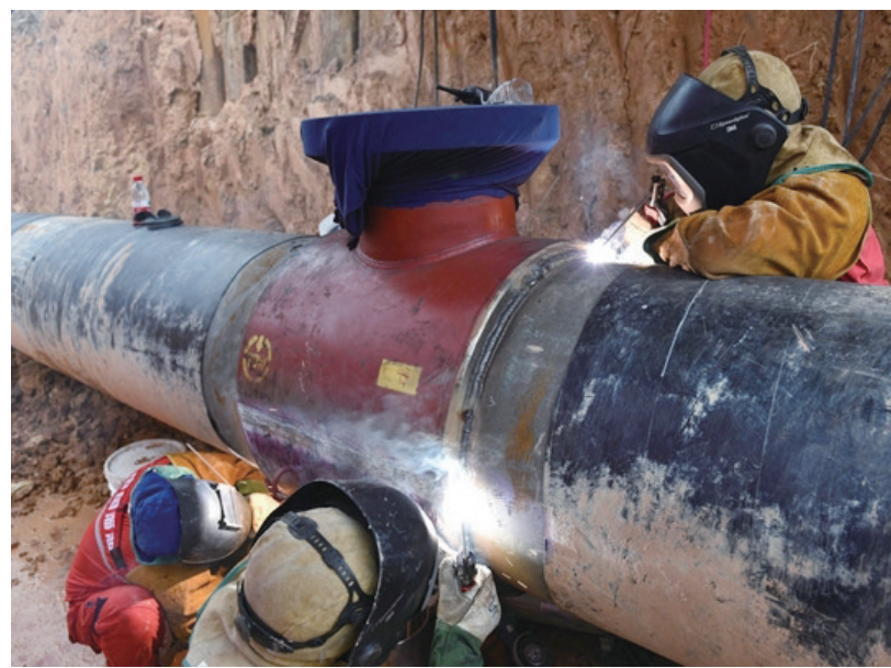
图为员工在进行厦门电厂支管线缺陷管道换管作业
