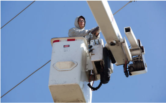
王舒平借助绝缘斗臂车带电处理电网
