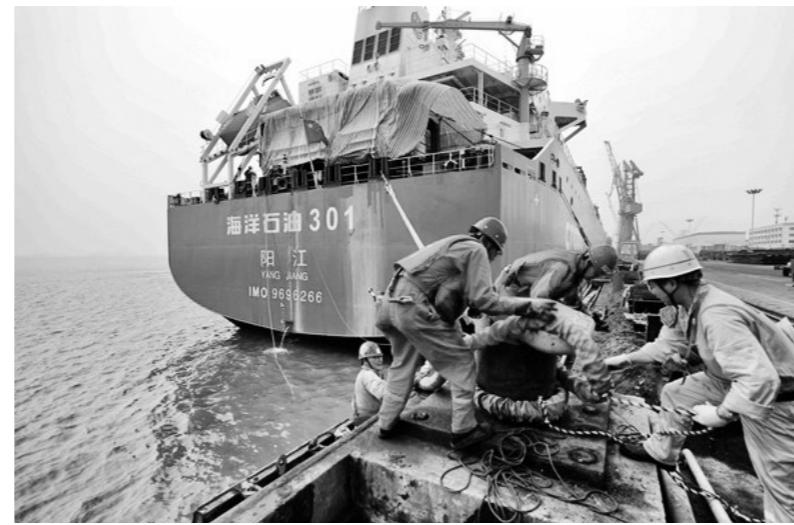
11月16日,在海洋石油工程股份有限公司建造事业部(下称海油工程建造事业部)青岛场地施工现场,机管电仪作业部员工正在为曹妃甸11-1/11-6油田综合调整项目CEPJ导管架泥浆管线切割就位孔。
