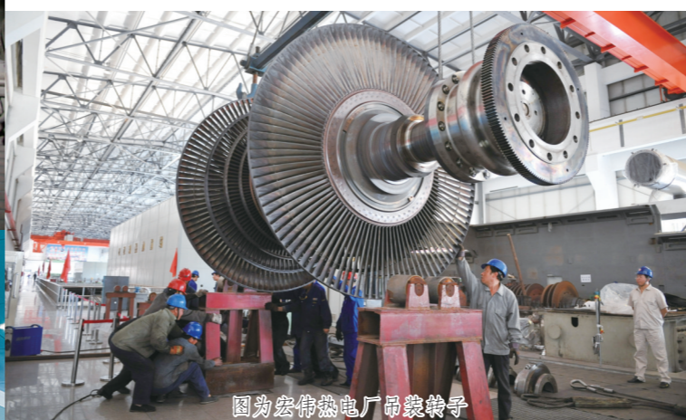
图为宏伟热电厂吊装转子
