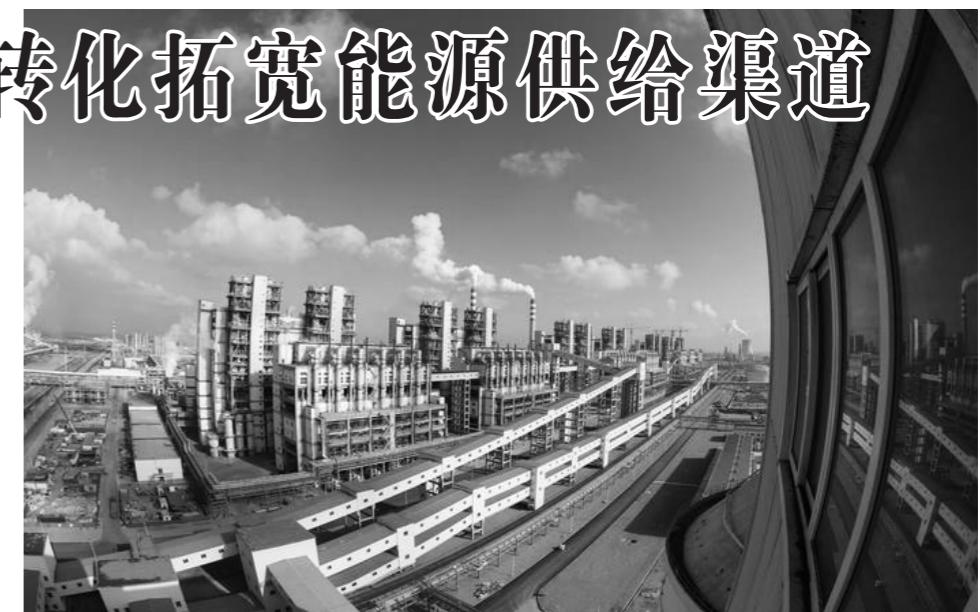
外同类产品相比,“神宁炉”采用干煤粉加压气化成套技术,具有投资低、效率高、操作简便、运行可靠等特点,不仅能吃精煤,也能吃劣质煤,胃口大,消化好,煤制油项目28台气化炉日消化煤炭达2200吨。”黄斌介绍说,“神宁炉”在专利运用中取得了良好的经济效益和市场价值,为我国劣质煤清洁利用提供了途径。目前,该技术已累计产生经济收益3.9亿元,被国家能源局列入煤炭安全绿色开发、清洁高效利用先进技术与装备推荐目录。
