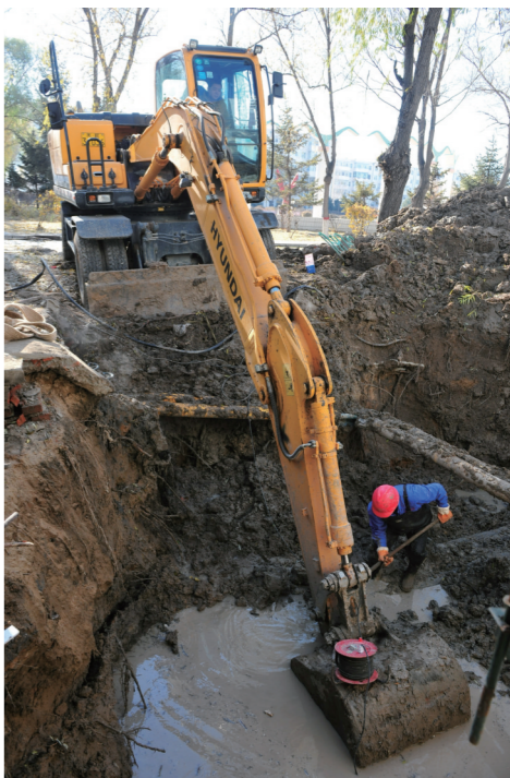
东湖物业二分公司维修工人检修供热管
