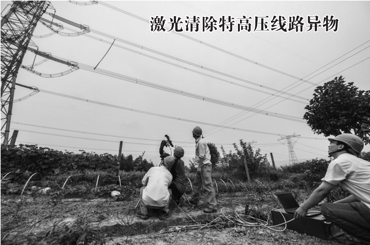
9 月 6 日，工作人员正在特高压线路下使用激光烧熔高压线上的塑料薄膜异物。当日，浙江湖州首次运用激光远程异物清除仪消除 1000 千伏特高压线路隐患，成功清除导线异物。激光远程异物清除仪采用激光器作为基础，利用激光的热效应除去异物，操作便捷，对电网设备无损伤。 新华社记者 徐昱 摄
