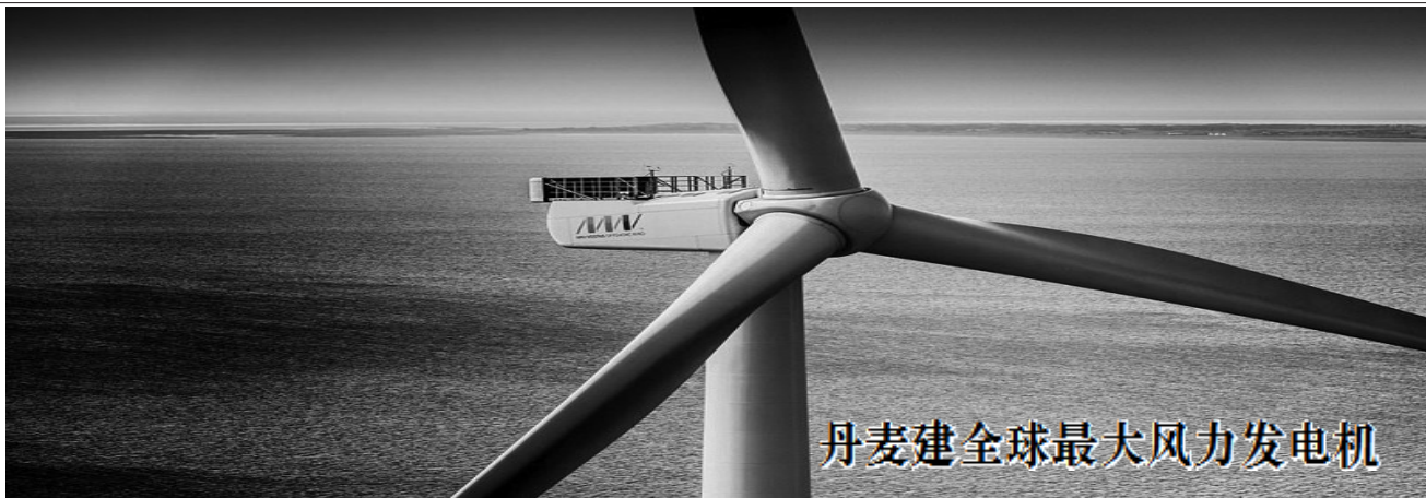
世界上最大的风力发电机安装于丹麦Maede,高达220米,3个巨型叶片均长达80米。此外,它也是全球最强大的风力发电机,24小时内能发电26万度,足以为数百户家庭供电1个月。 环球网
