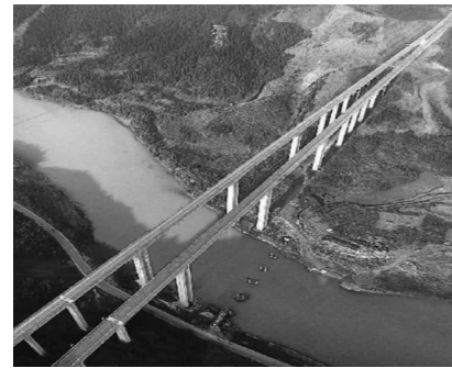
图为贵州省榕江县厦蓉高速公路都柳江特大桥。
