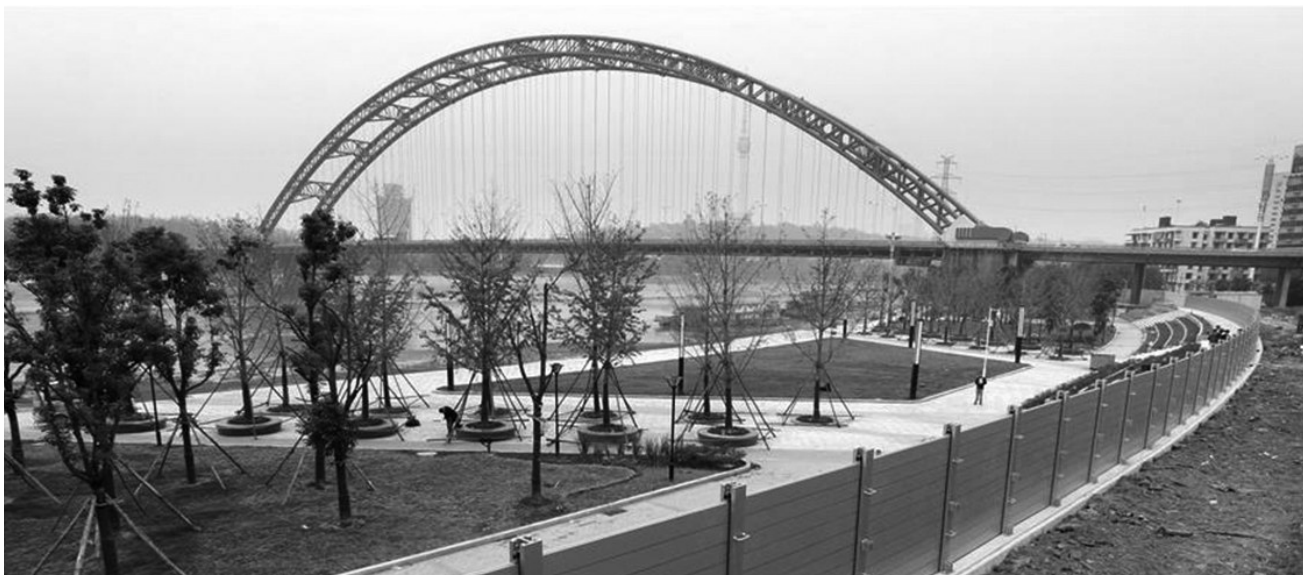
由武汉市城市防洪勘测设计院牵头自主研发的拼装式防洪墙,日前在湖北汉口江滩流通巷段投入使用。防洪墙挡板为特殊材质的铝合金,强度较大,能够顶住洪水长时间浸泡和高强度加压。 新华社
