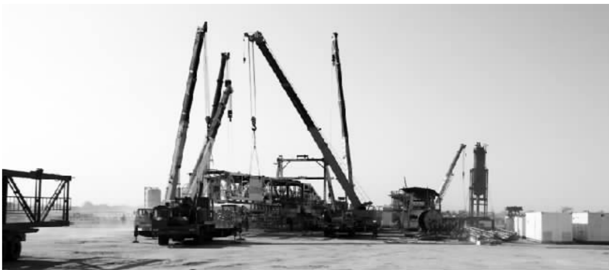
图为GW75队正在安装井架
