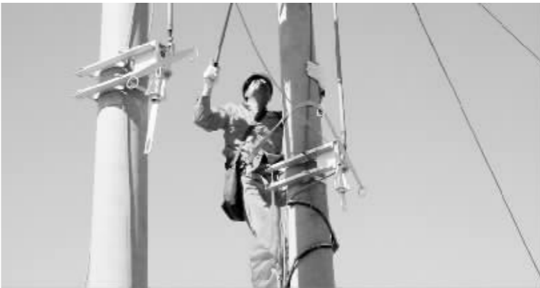
图为王洪良在进行电网设备检修工作
