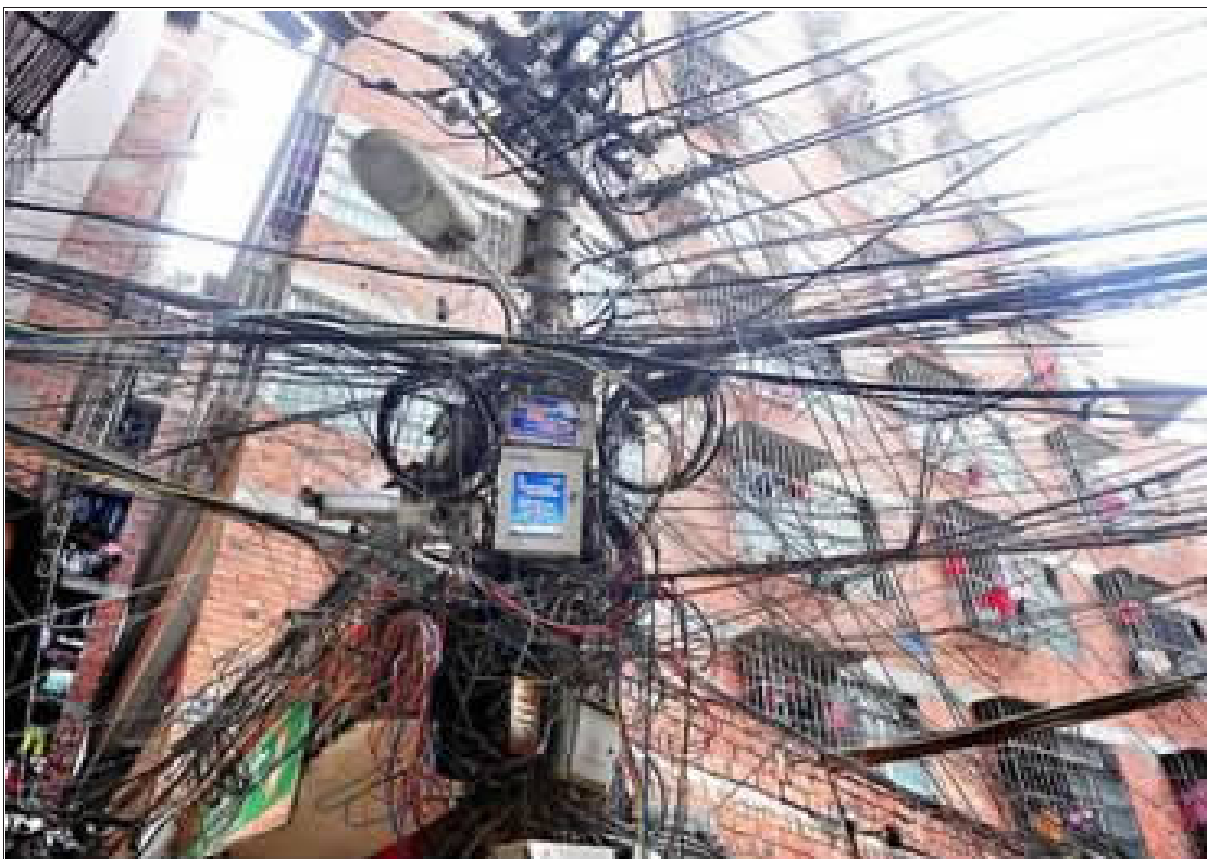
在广西南宁市的一些城中村,大量线路不按要求架设,密密麻麻犹如“蜘蛛网”,极易引发触电、火灾……目前,南宁市有关部门已经开始着手清理这些电线“蜘蛛网”。 新华网 摄 / 黄孝邦
