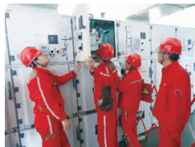
普光气田电网检修工程-变电所检修
