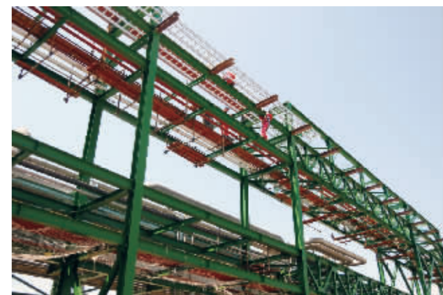
化工装置工程高空敷设电缆桥架
