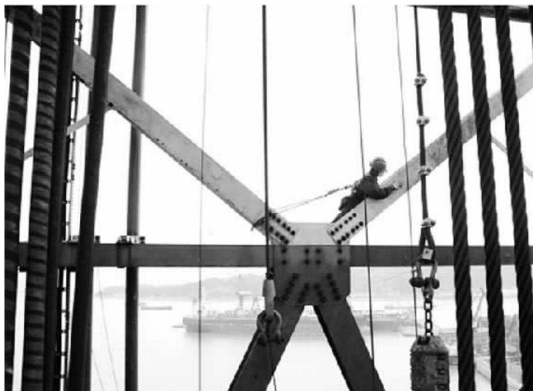
10月以来，“海洋石油941”平台出现了成群的“蜘蛛人”。他们在最高达80米的井架上爬上爬下，一寸寸地洗去钢结构表面的油污和灰尘。据平台高级队长李福松介绍，这是平台自2006年投产以来，首次对井架进行全面防腐作业。平台30多名钻工在培训后，承揽了所有清洗和防腐工作，防腐总面积超过1300平方米，直接节约人工费用百万元。
